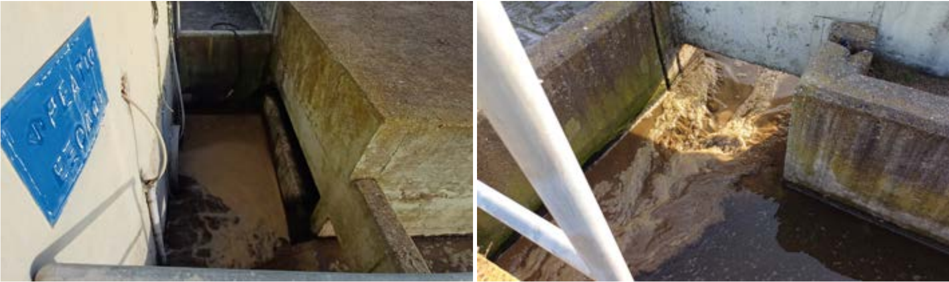
Η ροή του νερού και δυνωγ υλικών μεταφέρει στο σημείο που γίνεται η αυτόματη δειγματοληψία
